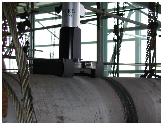
그림. 1 계장화압입시험 적용 모습 (영흥 화력 발전소 가동 전 Main Stream Line 용접부 강도 평가)
