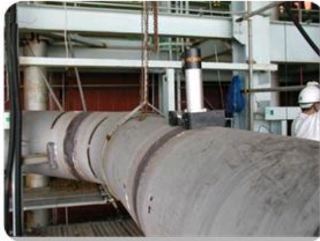
영풍 화력 발전소 기동 전 실험 (Main Steam Line)
